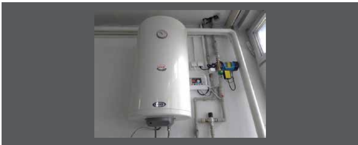
FIGURA 23. Elemente nga instalimet e brendshme të sistemit me kolektorë vakum me nxehje direkte të ujit të ngrohtë sanitar
