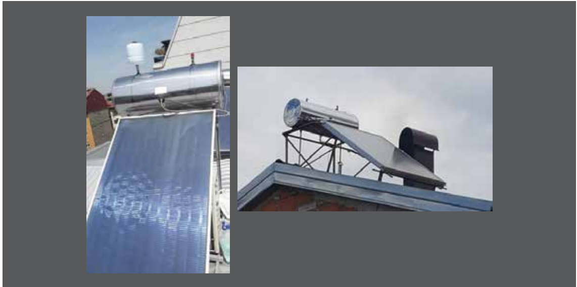
FIGURA 21. Sistemi termosifonik me kolektor të rrafshtë pllakaq
