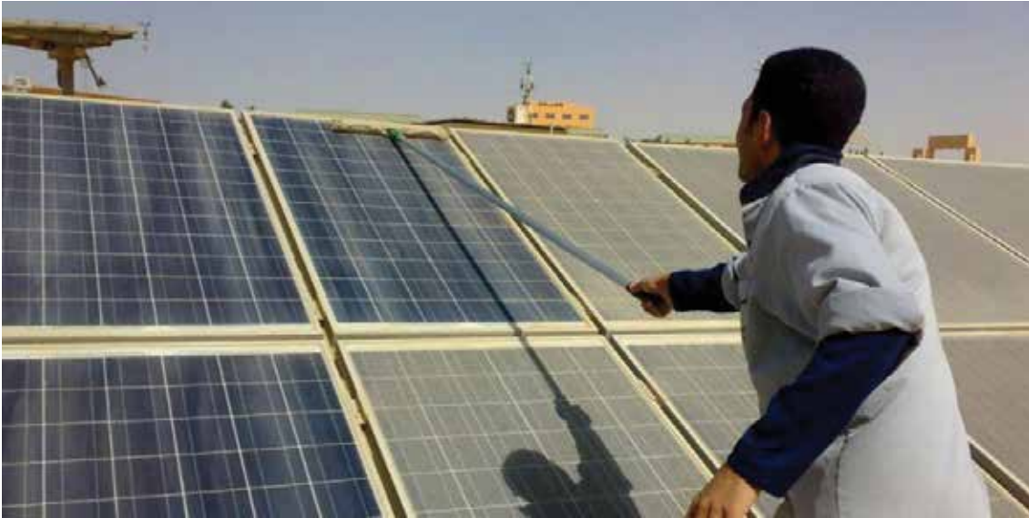
FIGURA 26. Mirëmbajtja e paneleve diellore të vëna në çati
