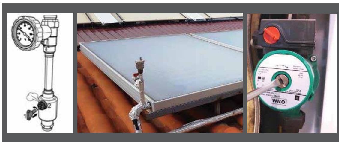
FIGURA 18. Mënyrat e nxjerrjes së ajrit nga sistemi
