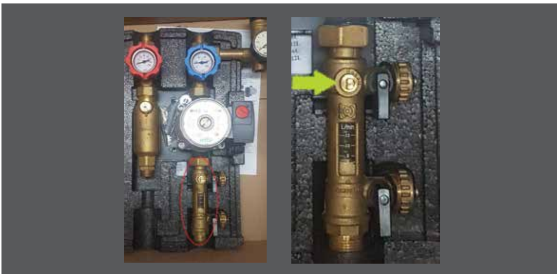
FIGURA 19. Instalim për matjen e rrjedhjes te kolektorët diellorë
