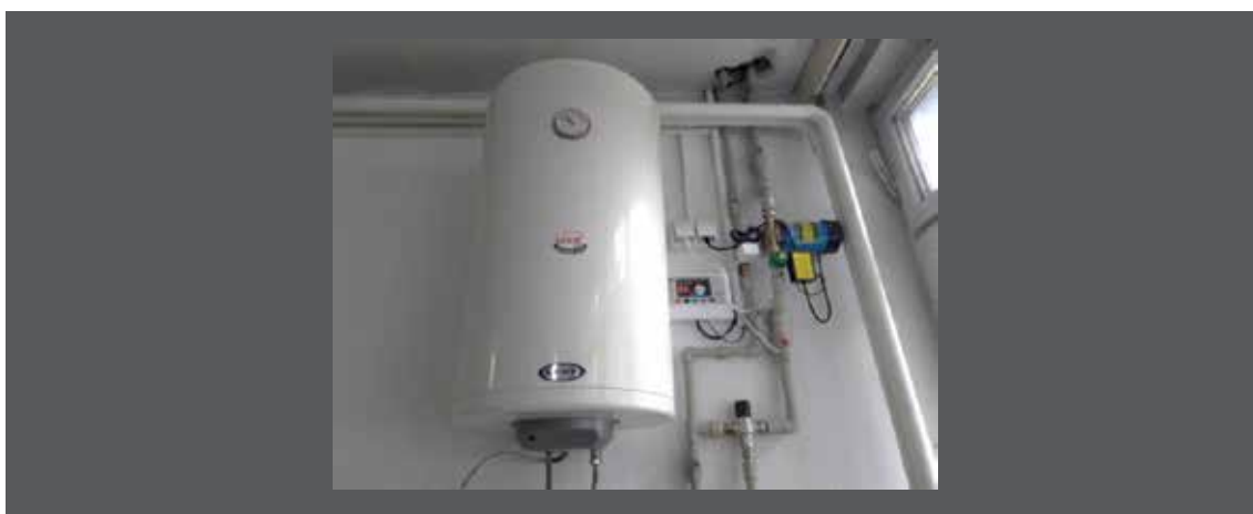
СЛИКА 23. Елементи од внатрешна инсталација на систем со вакуумски колектори со директно загревање на санитарната топла вода
