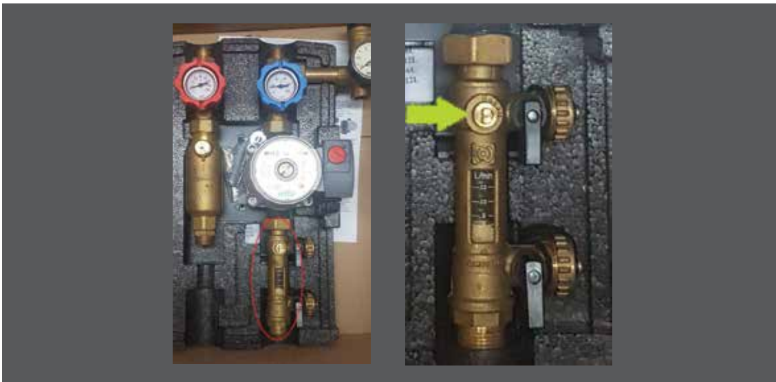
СЛИКА 19. Уред за мерење проток кај сончевите колектори
