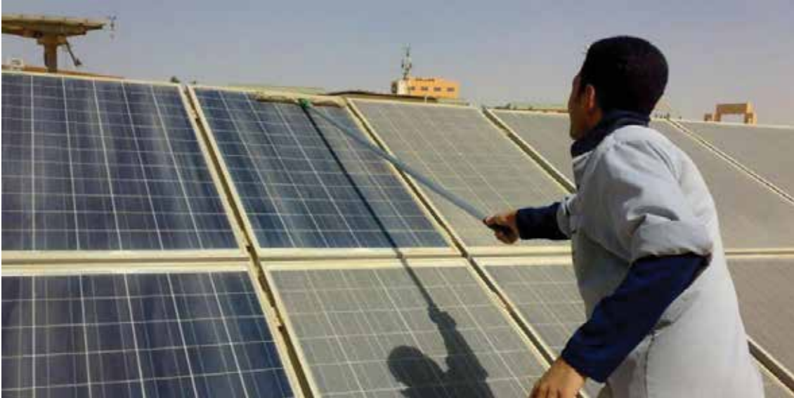
СЛИКА 26. Одржување на сончевите панели поставени на покрив
