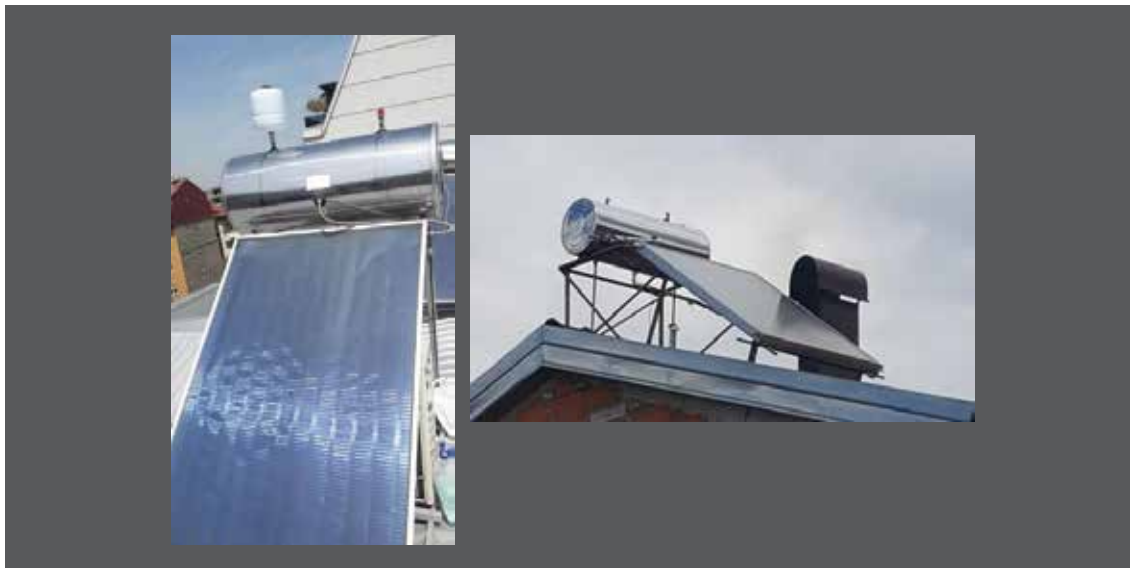
СЛИКА 21. Термосифонски систем со рамен плочест колектор
